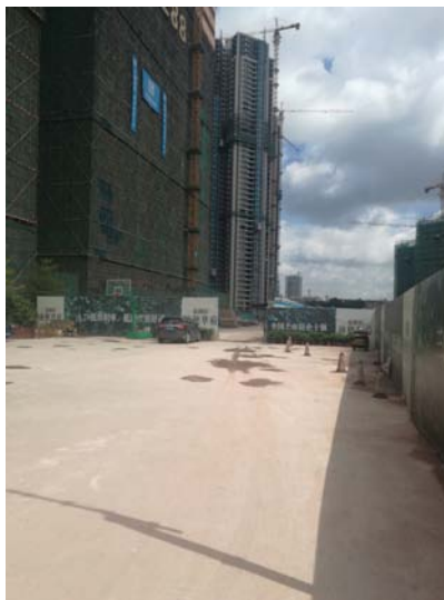
地上建筑施工 2016 年 6 月 28 日
