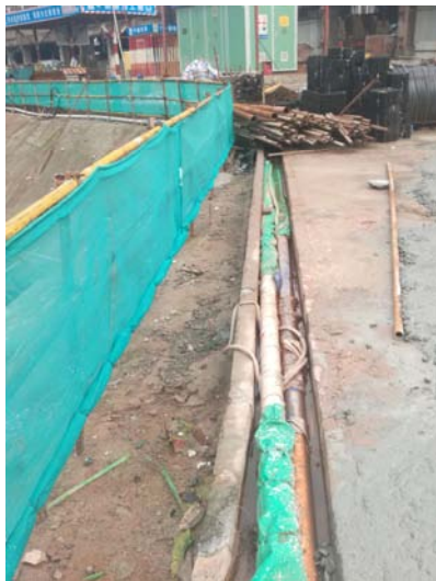
基坑防护 2016 年 3 月 28 日
