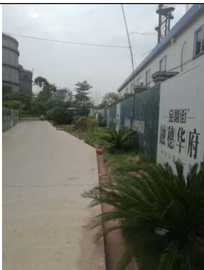
施工工区排水沟 2016 年 3 月 28 日
