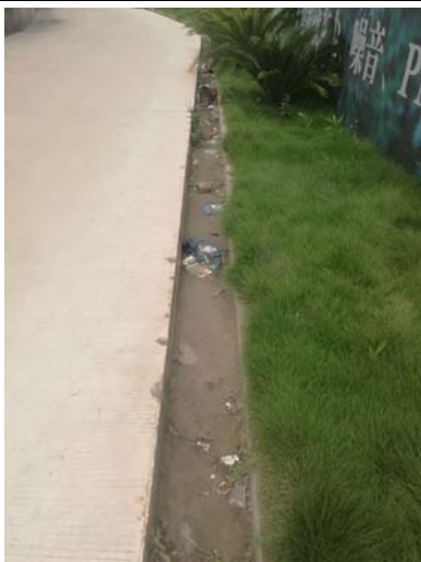
施工工区排水沟 2016 年 6 月 28 日
