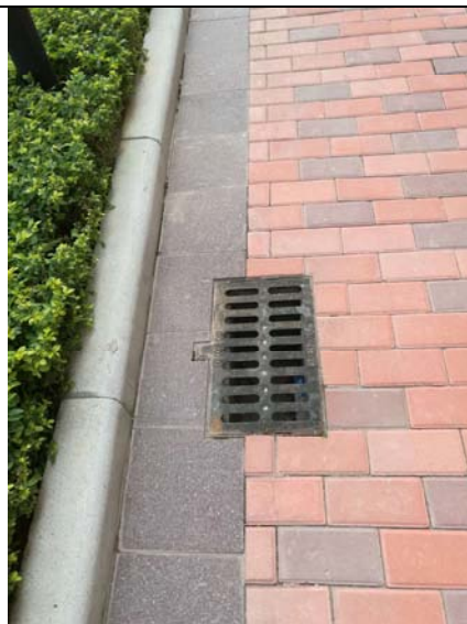
道路硬化+排水沟 2018 年 2 月 1 日
