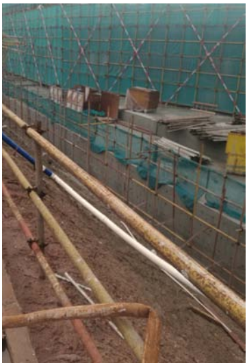
基坑防护 2016 年 3 月 28 日
