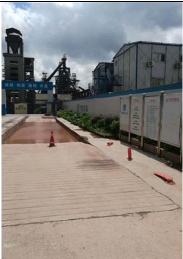
洗车槽 2016 年 6 月 28 日
