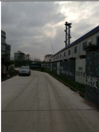
施工区及进场道路 2016 年 3 月 28 日
