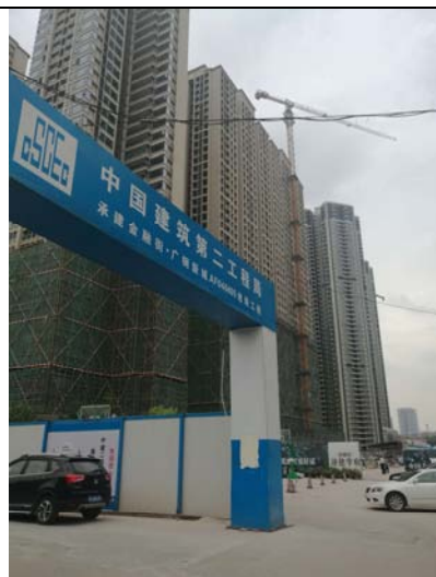
地上建筑施工 2016 年 9 月 28 日
