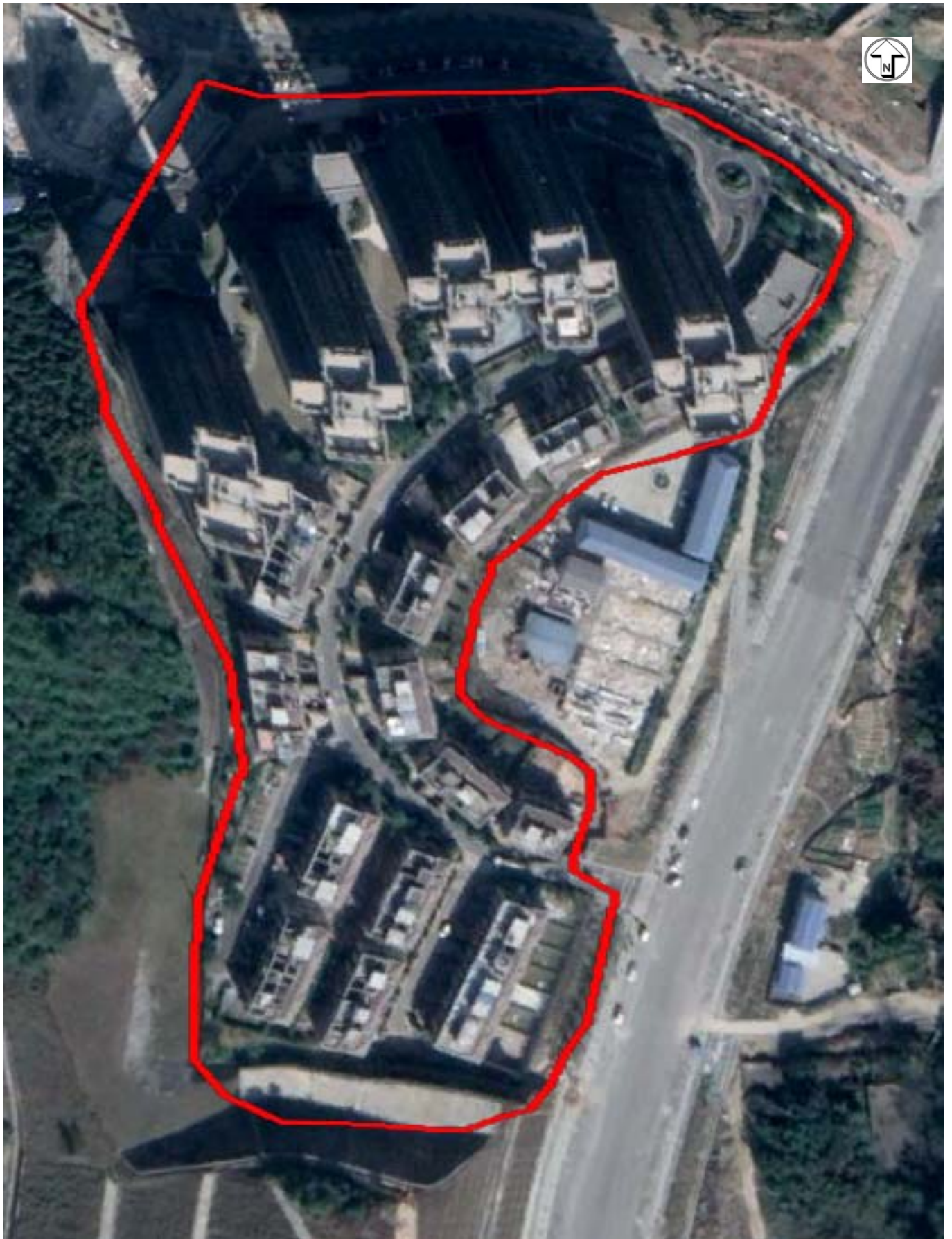
附图 4、项目建设后遥感影像图（2018 年 1 月）
