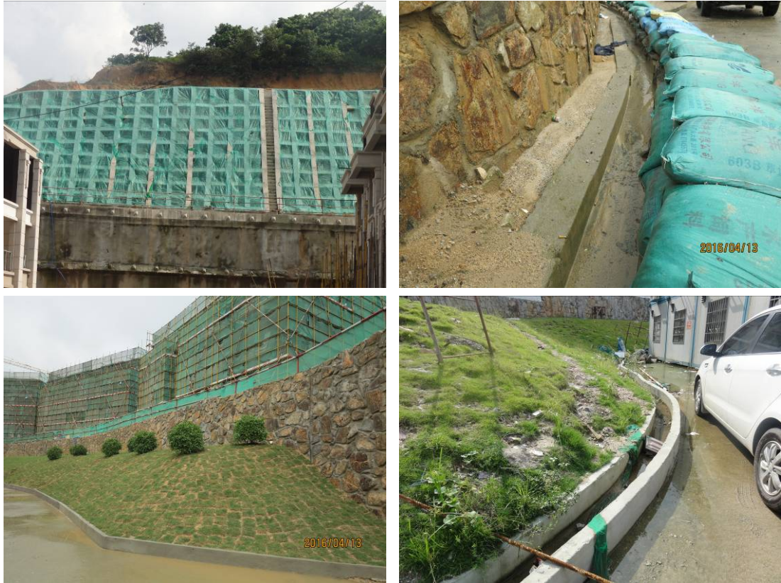
图 4-3 项目区水土保持临时措施（已拆除）
