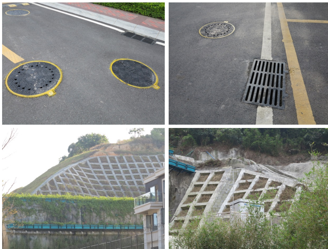
图 4-1 项目区水土保持工程措施现状
